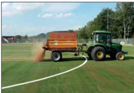
Apport de matériaux de lestage (Sable quartz, liège, granulats)
