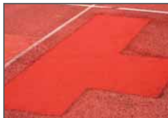
Réparation du revêtement
