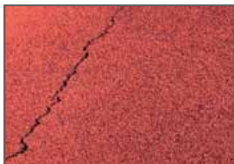
Réparation de fissures
